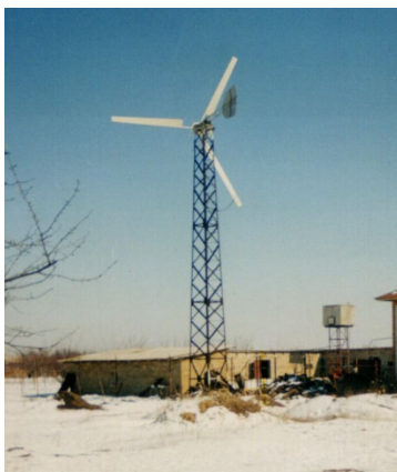
Рисунок 2 – Власна присадибна ВЕУ: діаметр ВК 8 м; кількість лопатей – 3; висота вежі 13 м; потужність P = 5-7,5 кВт; частота обертання ВК – 1,2 \text{ с}^{-1}
